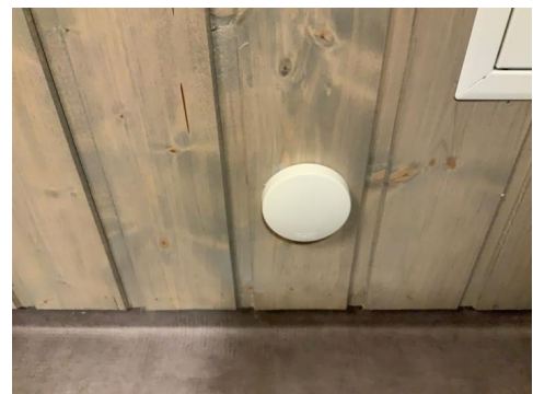
Lekkasjesikring fra vannskap.
