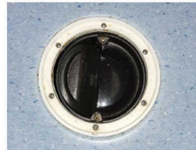
Membran, tettesjikt og overgang til sluk. - [Sluk badrom.]
