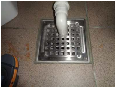
Sluk med fast skrudd rist.
