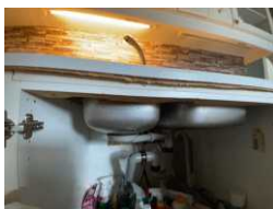
Fuktskadet benkeplate/laminat.
