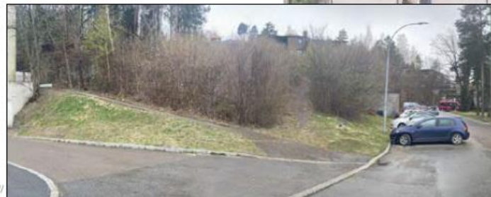
Bratt skråning med tett vegetasjon Side 30 av 41
