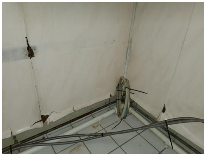
Kommentar - [Veggoverflater bad]
