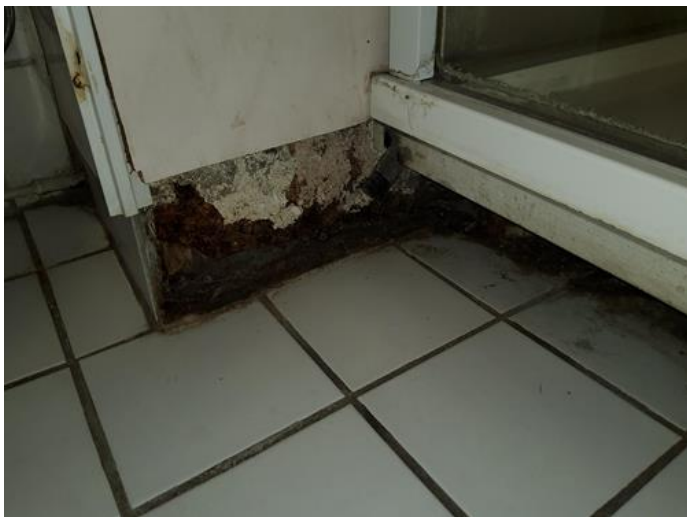
Kommentar - [Veggoverflater bad]
