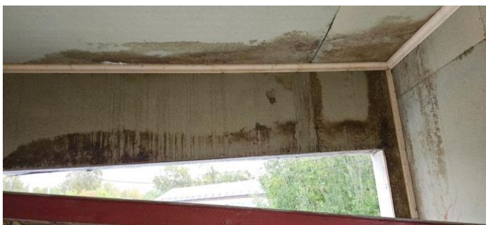
Underkant balkongdekke (garasje)
