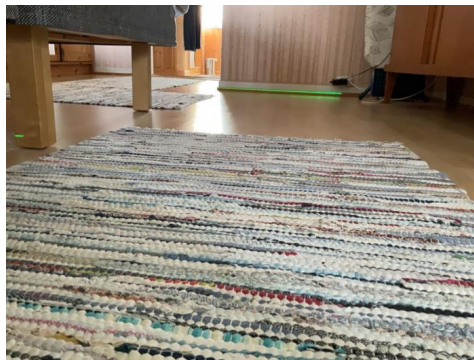
Store skjevheter i etasjeskiller 2.etg.
