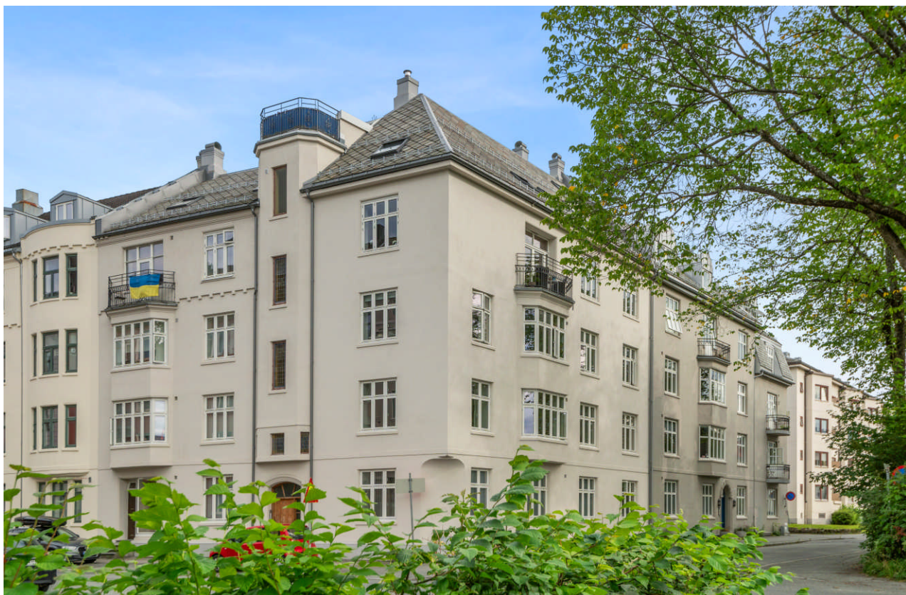
Klassisk og omfattende rehabilitert bygård med sentral og tilbaketrukket beliggenhet like ved NTNU og St. Olavs.
