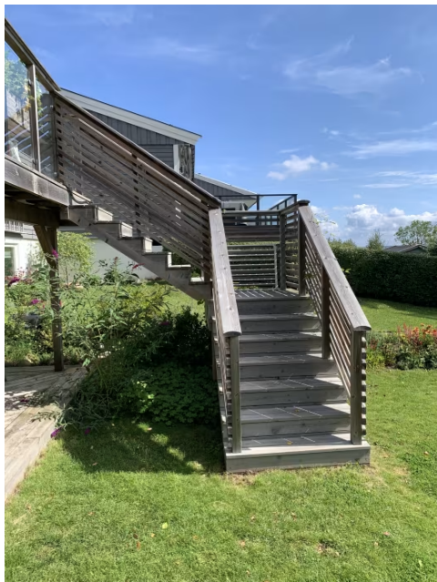
Plassbygd utetrapp i trekonstruksjon, fra terrasse mot hagen.
