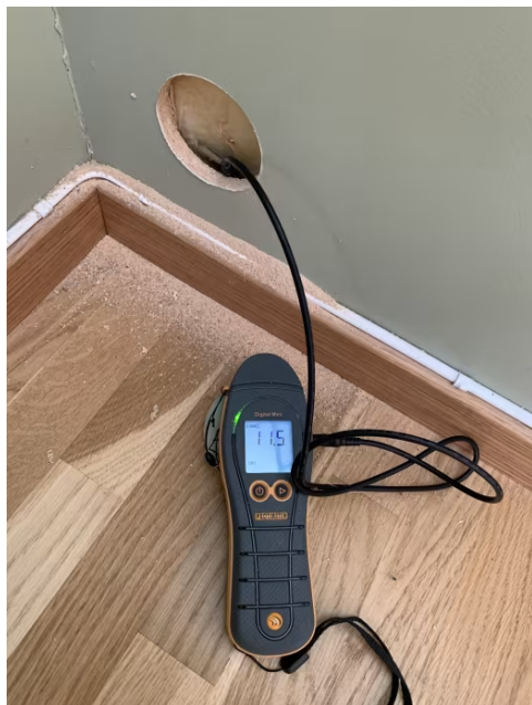
Hulltaking med fuktmåling baderom 2. etg
