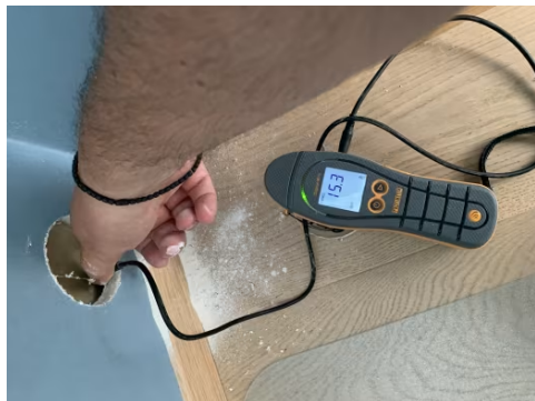
Hulltaking med fuktmåling på soverom i 1te etg.
