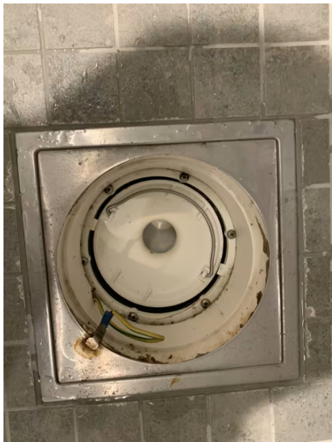
Baderomssluk plassert i dusjsonen.
