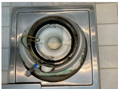
Baderomsluk 2. etg plassert i dusjsonen.
