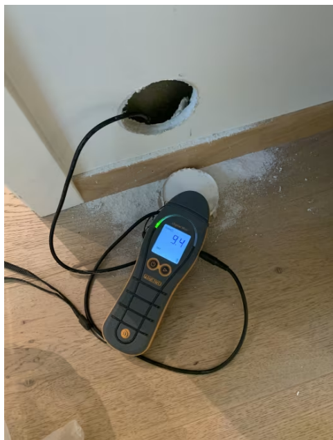
Hulltaking med fuktmåling vaskerom.
