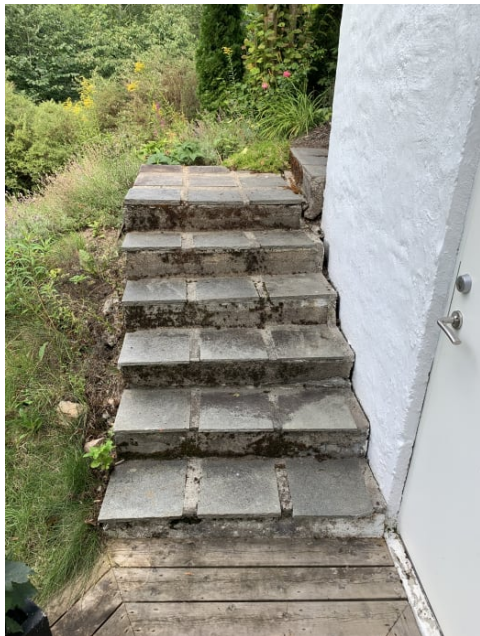
Betongtrapp fra nordvest mot hagen.
