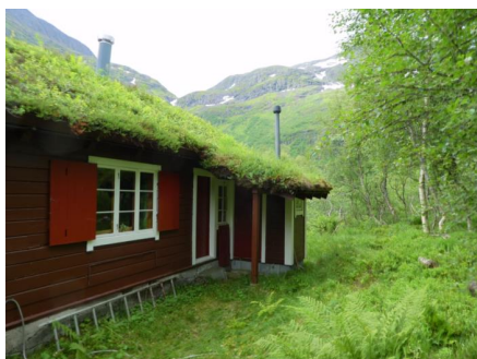
Hellende terreng på nordsiden av bygningen
