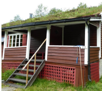
Tretrapp til altan og hovedinngang
