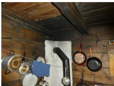
Gammelt ildsted og røykpie som er sanert men ikke revet.
