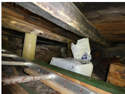
Bjelkelag med ny understøttelse
