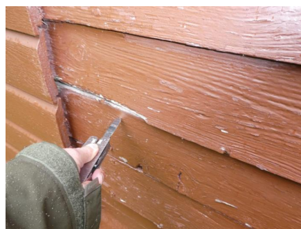
Kledning i vestveggen
