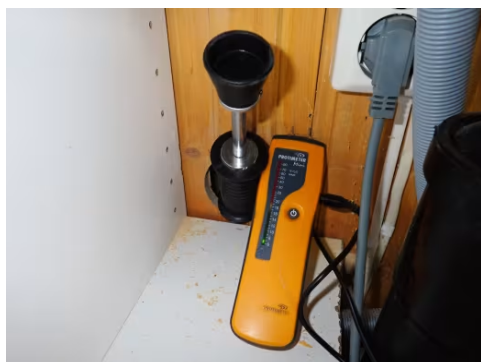
Hulltaking og fuktsøk, ingen fukt oppdaget i konstruksjonen.
