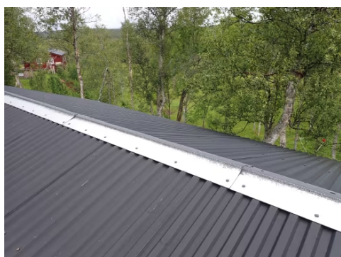
Avflassing av overflatebelegg i mønekam.
