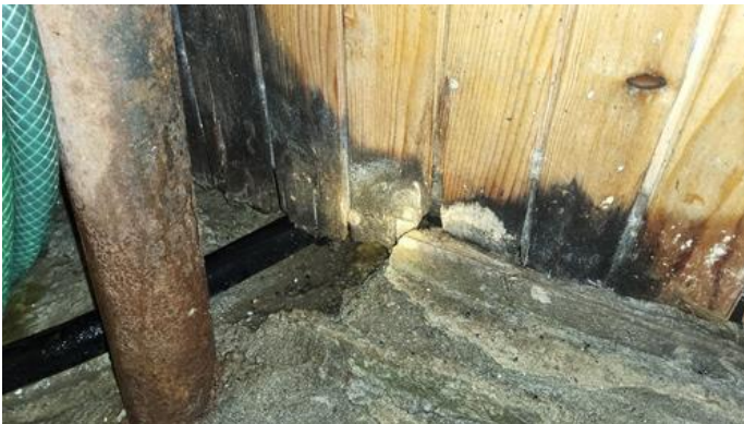
Helhetsvurdering - [Innvendig kjellervegg]
