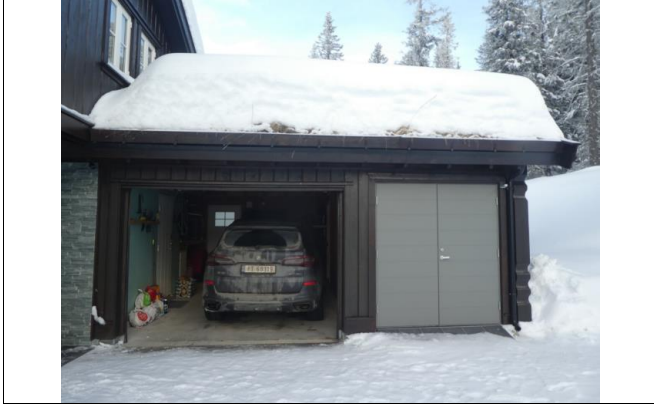
Garasje bygget inntil hytte
