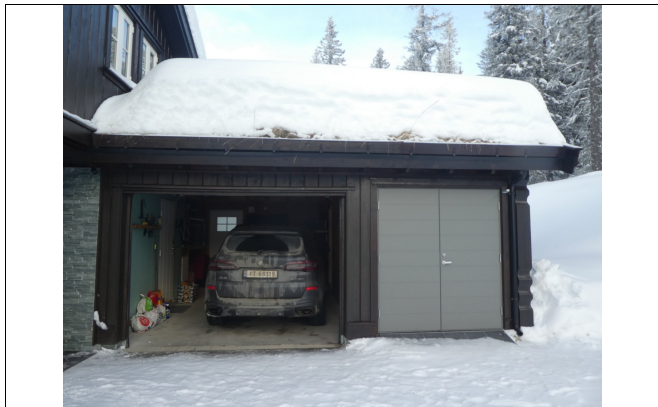
Garasje bygget inntil hytte
