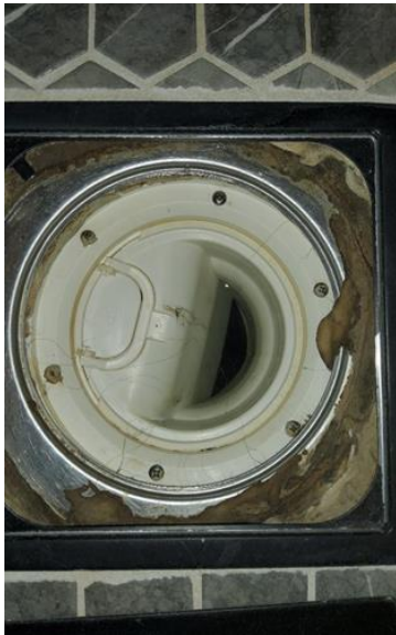
Membran, tettesjikt og overgang til sluk. - [Hovedsluk bad]
