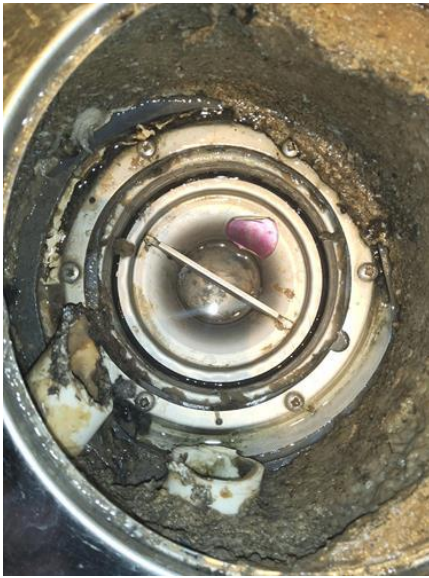
Våtrom - [Sluk bad]
