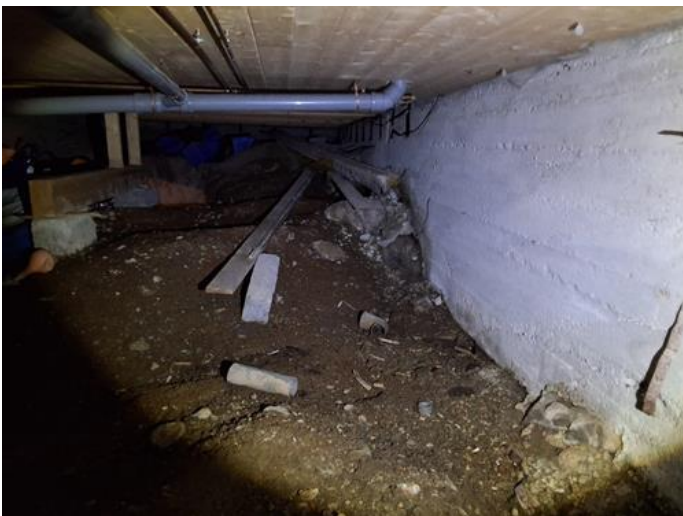
Innvendig - [Krypkjeller og rørlegg]
