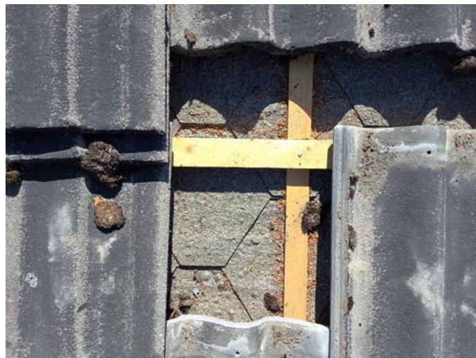
Utvendig - [Undertak og slisser/lekter]
