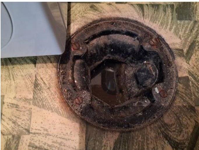
Våtrom - [Sluk på vaskerommet]
