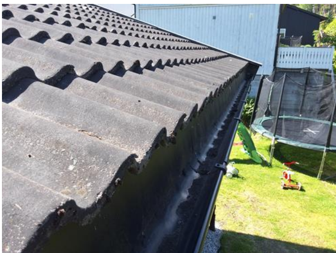
Utvendig - [Takrenne og takstein]
