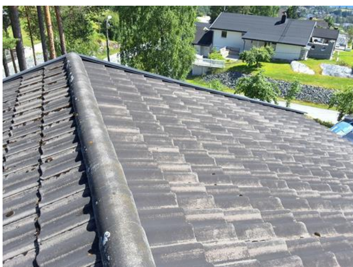
Utvendig - [Møne og takflate]
