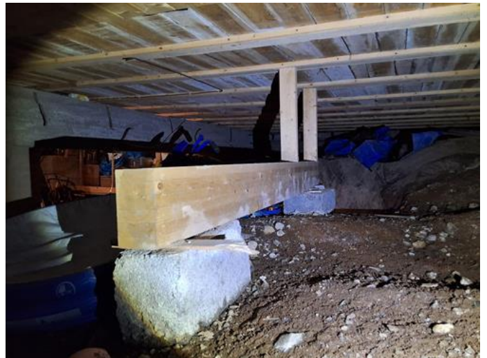
Innvendig - [Ettermontert drager i krypkjeller]
