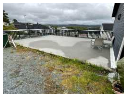
Terrasse over garasjer. Det er støpt dekke med rekkverk.
