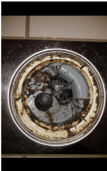
Membran, tettesjikt og overgang til sluk. - [Sluk bad hoveddel ]
