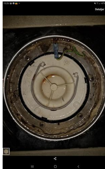
Membran, tettesjikt og overgang til sluk. - [Sluk bad hybel ]
