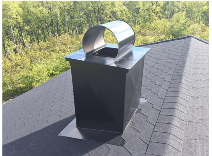
Utvendig - [Blikkbeslått pipe]
