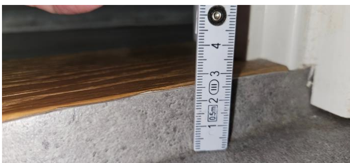
Oppbrett mot terskel
