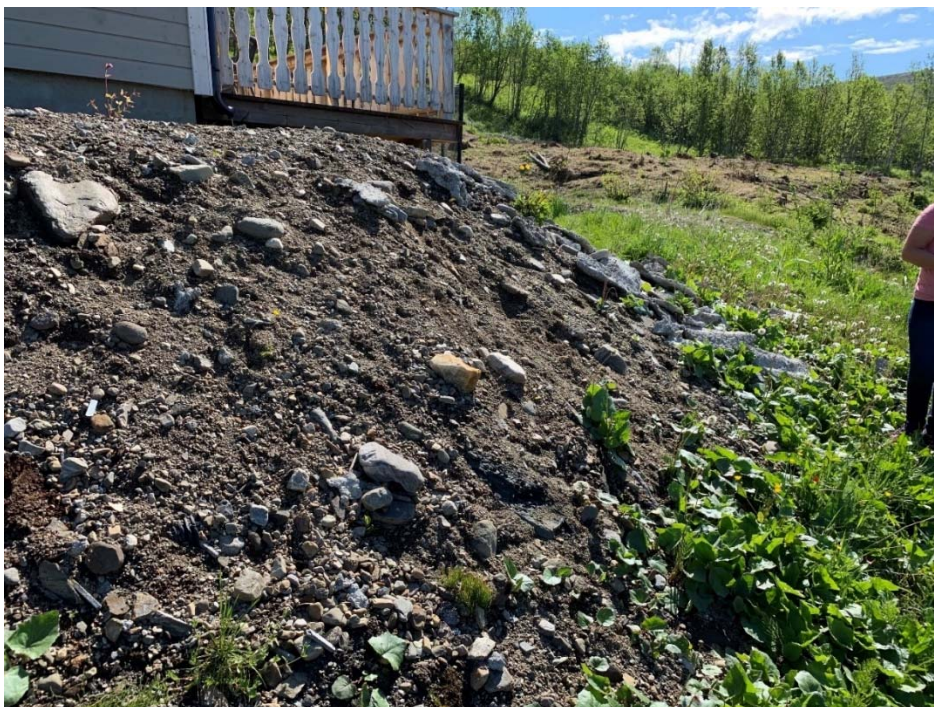
Figur 6 Fylling i forkant av bolighus.
