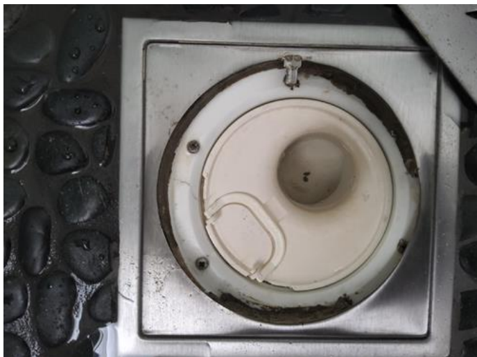
Avløpsrør (ink. sluk) - [Sluk på bad 2.]
