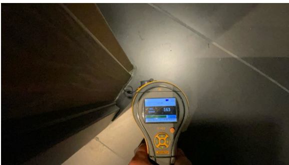
Fuktsøk er utført på gulv ved dør mellom bad og garderobe. Ingen forhøyde fuktavvik er målt
