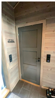
Dør til bad sett fra gang m/trapp
