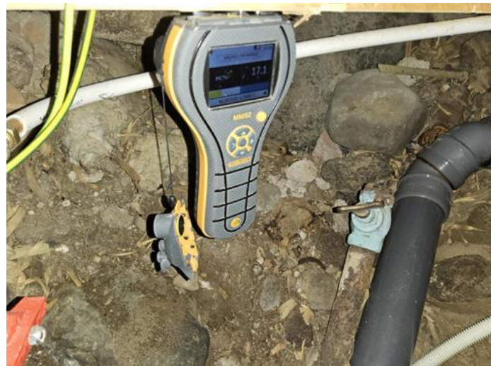
Krypekjeller - [Fuktmåling kryppgrunn]
