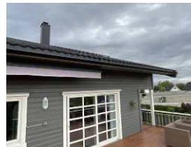
Hovedtaket er ett saltak, tekket med decra takplater. Ingen avvik registreres med dette taket.
