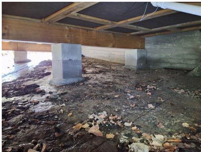
Utvendig - [Fundamenter under tilbygg fra 2012]
