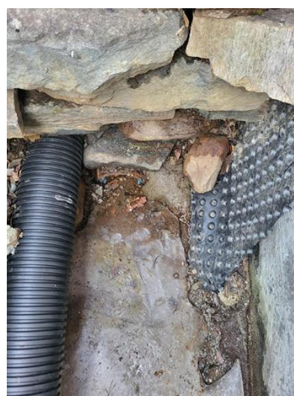
Utvendig - [Utløp drenering ved inngang/terrasse]
