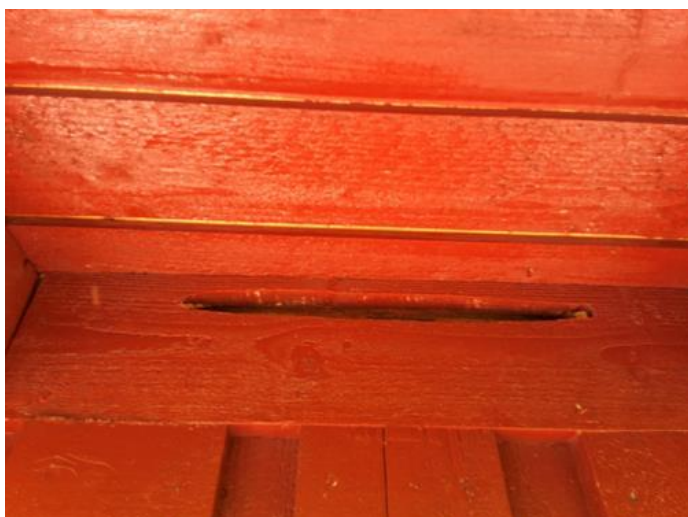
Utvendig - [Luftespalte i sperrefyllinger i tilbygg. ]
