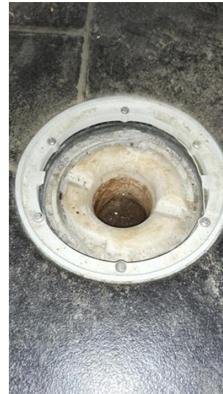
Overflater gulv - [Sluk bod i hoveddel]
