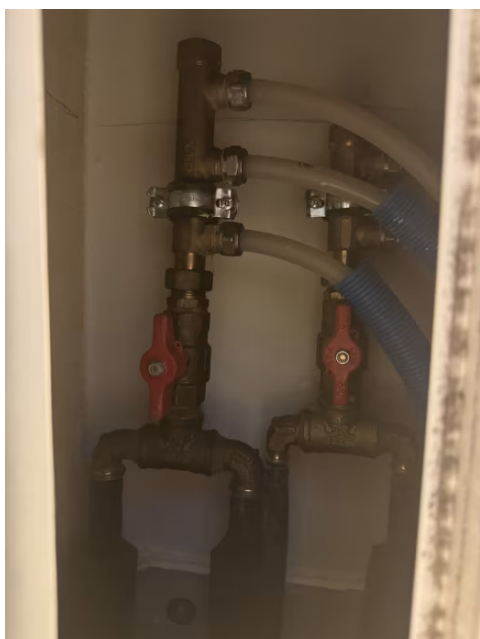
Vannrør i plast - koblingskap i himling på toalettrom og bad med stoppekraner.
