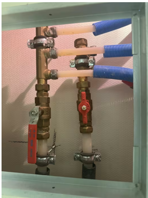
Vannrør i plast - koblingskap i himling på toalettrom og bad med stoppekraner.
