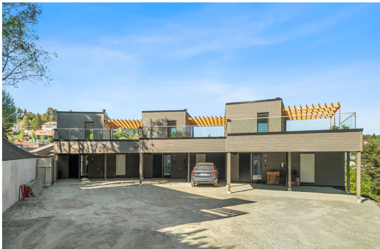
Dobbel carport med god takhøyde og stor gårdsplass.
