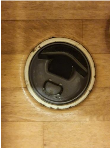
Toalettrom (Ikke våtrom) - [Sluk toalettrom ]
