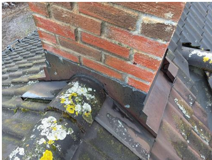
Utvendig - [Pipebeslag]
