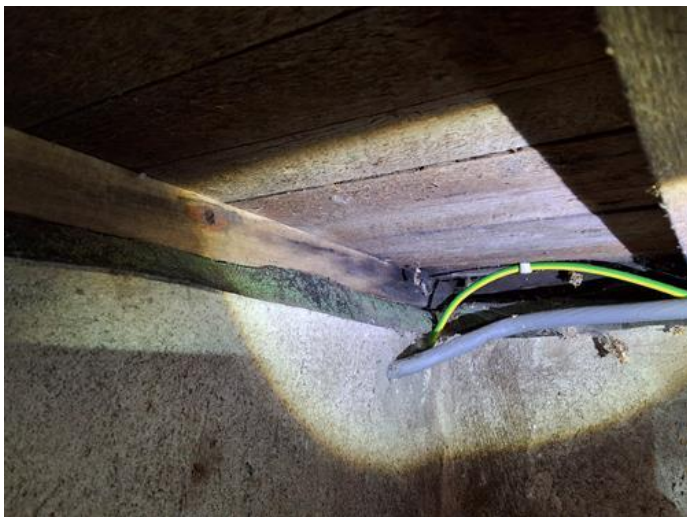
Rom under terreng (kjeller, underetasje, sokkeletasje) - [Fuktmerker og råtedannelse på bjelker/bunnsvill og stubbloft. ]
