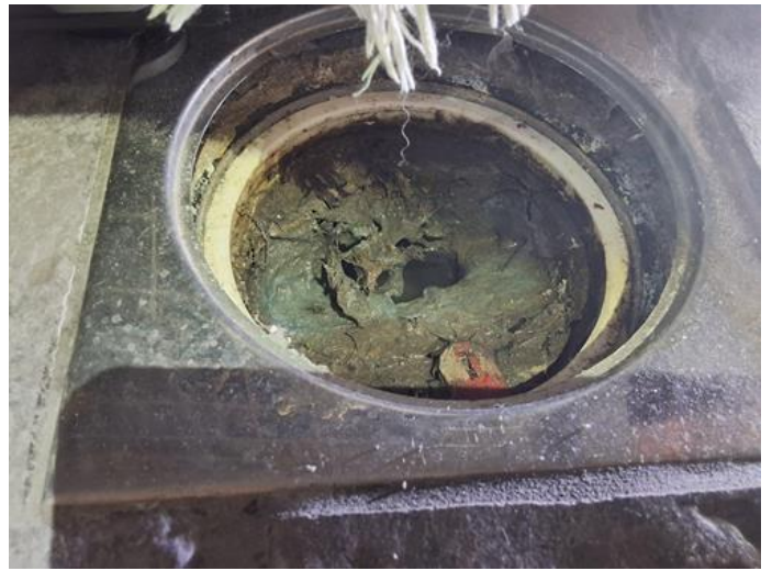
Våtrom - [Sluk på vaskerom]
