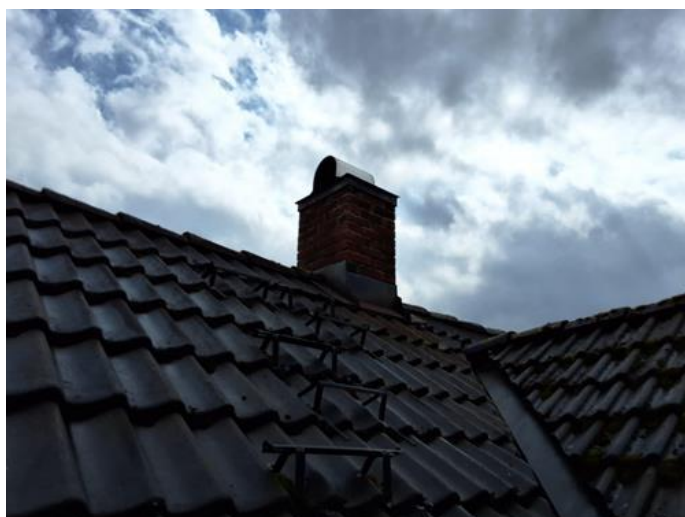
Utvendig - [Kilrenne og stigetrinn]
