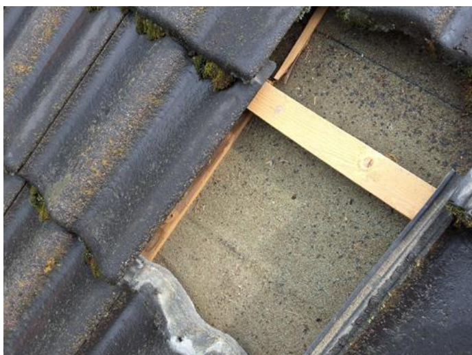
Utvendig - [Undertak og lekter eldste del. ]
