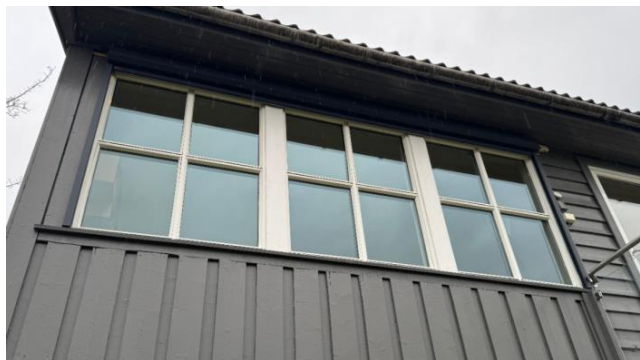
Bilde viser stuevindu med god tilstand.
