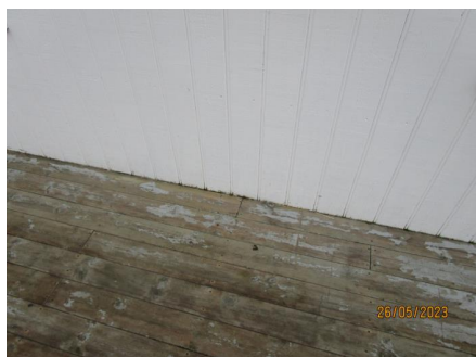
Overgang mellom vegg og terrasse.
