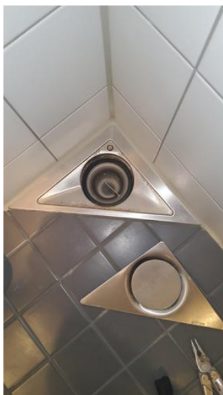
Våtrom - [Sluk bad]
