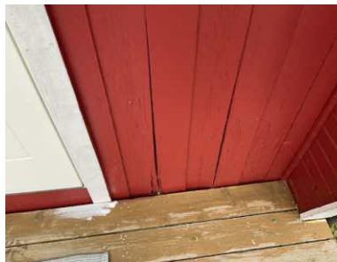
Råteskadet bordkledning.
