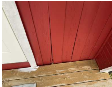
Råteskadet bordkledning.
