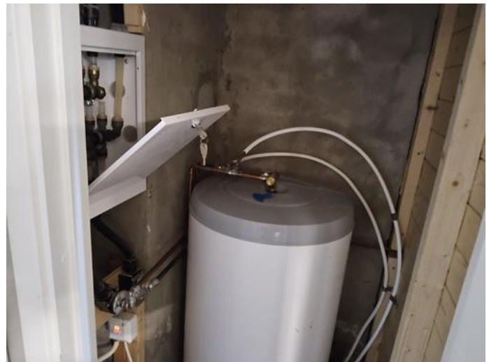
Tekniske anlegg, VVS anlegg (Sjekkpunkter utover det som er inkludert i andre rom) - [VVB og vannskap]
