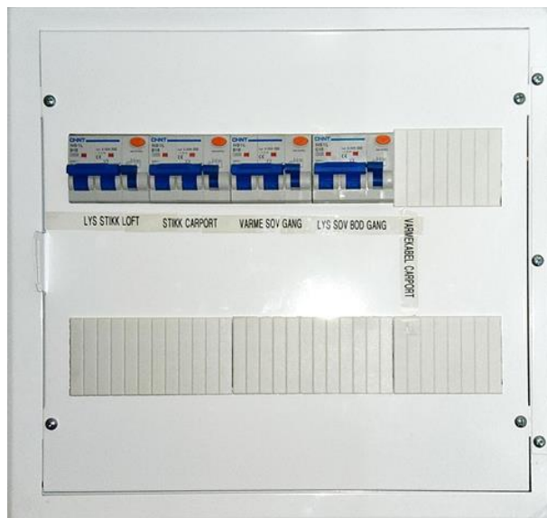
Forenklet vurdering av det elektriske anlegget - [Sikringskap omkleddingsrom]
