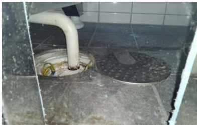
Membran, tettesjikt og overgang til sluk. - [Sluk bad 1.etasje]
