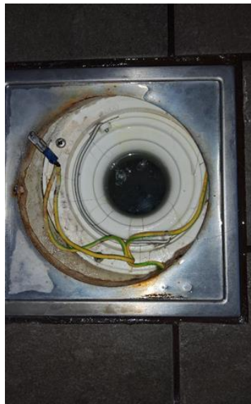
Membran, tettesjikt og overgang til sluk. - [Sluk bad 1.etasje ]
