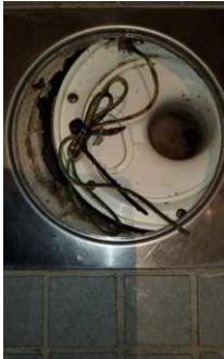
Membran, tettesjikt og overgang til sluk. - [Sluk bad underetasje]
