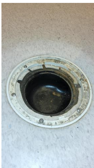
Overflater gulv - [Sluk teknisk rom]
