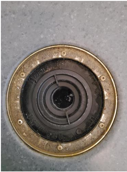
Membran, tettesjikt og overgang til sluk. - [Sluk]
