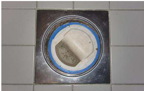
Membran, tettesjikt og overgang til sluk. - [Sluk bad.]
