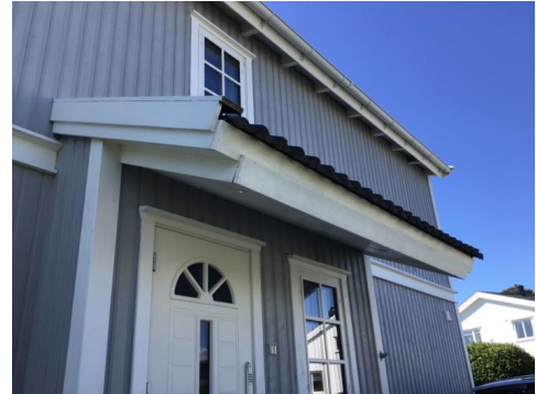
Mangler takrenne/nedløp
