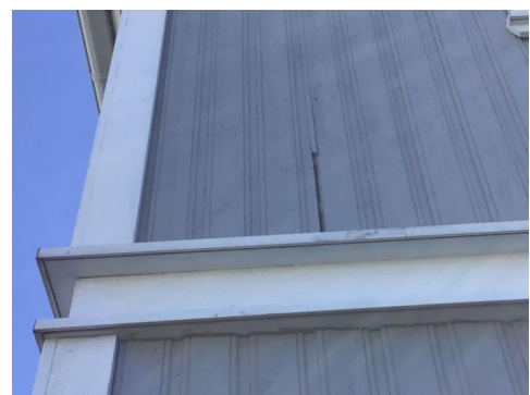
Skadet kledningsbord
