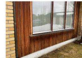
Tilbygg med profilert kledning og teglfasade.
