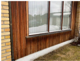
Tilbygg med profilt kledning og teglfasade.
