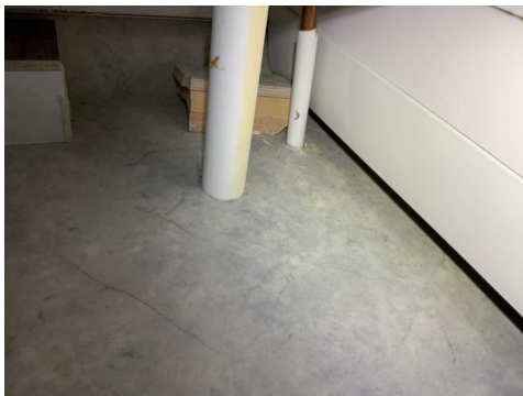
Utette rørgjennomføringer i gulvet.
