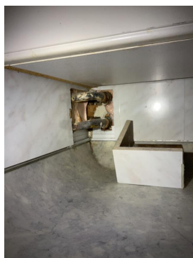
Utette rørgjennomføringer i gulvet.
