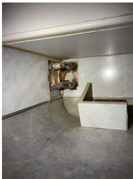
Utette rørgjennomføringer i gulvet.
